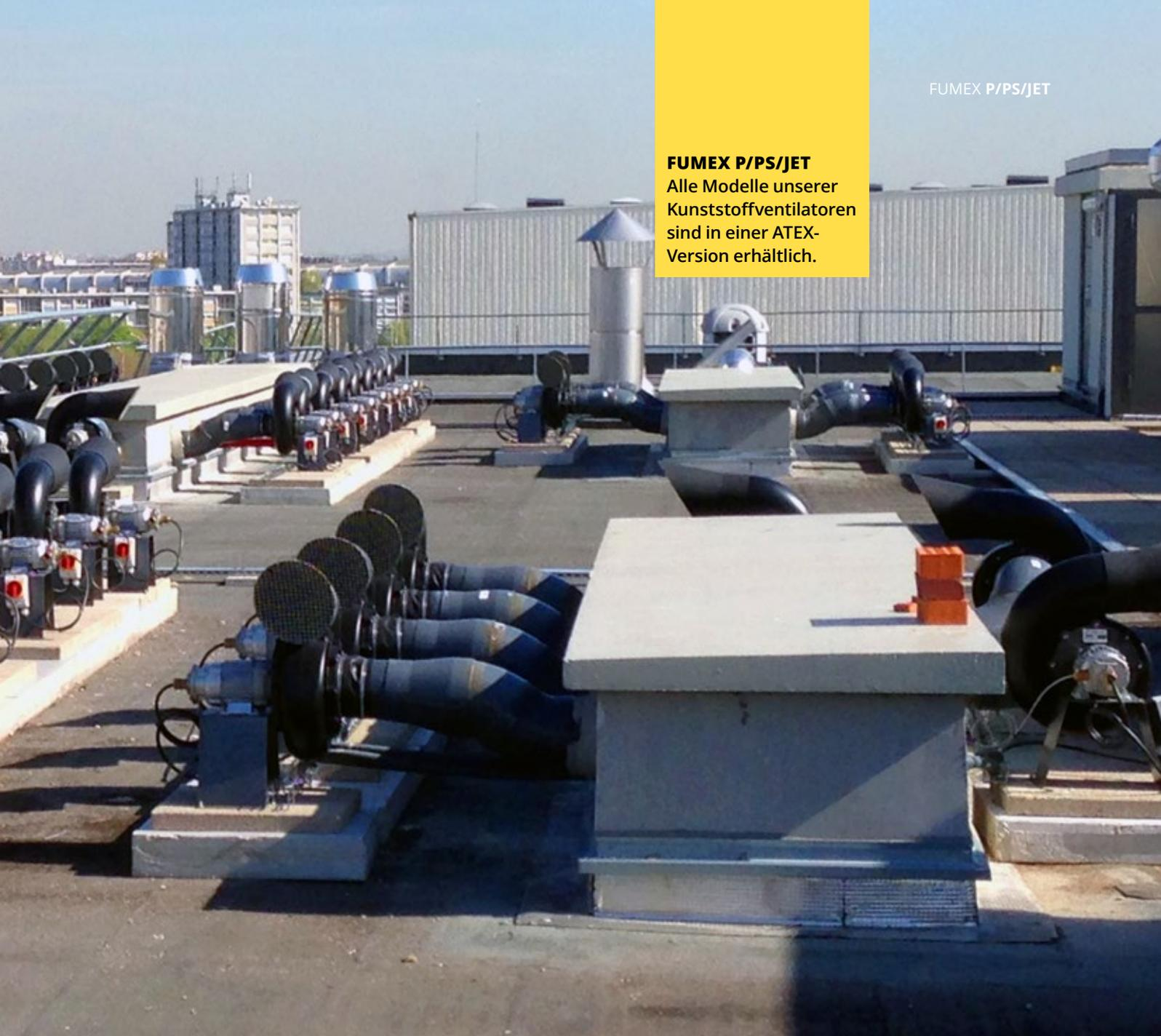
Die Ventilatoren sind komplett aus recycelbarem Polypropylen mit Edelstahlschrauben gefertigt. Entsprechend hoch ist ihre Beständigkeit gegen aggressive Chemikalien. Unsere Kunststoffventilatoren sind aber auch sehr gut für feuchte Umfelder geeignet.
